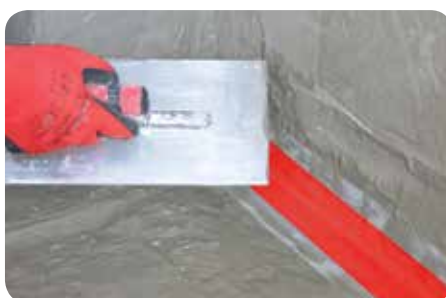
Postavljanje elastičnih traka u uglove
